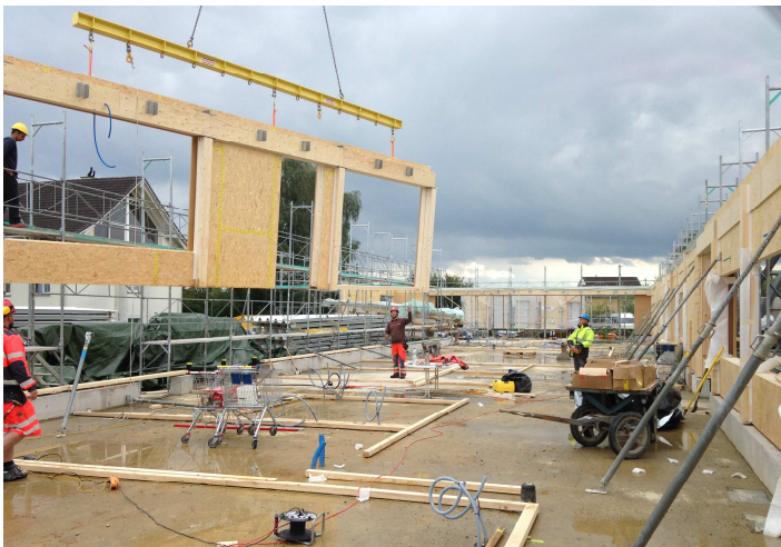
Die Arbeiten am neuen Schulhaus im Grund gehen planmässig voran. Aus heutiger Sicht steht dem Bezug des Schulhauses per Sommer 2018 nichts im Weg.
