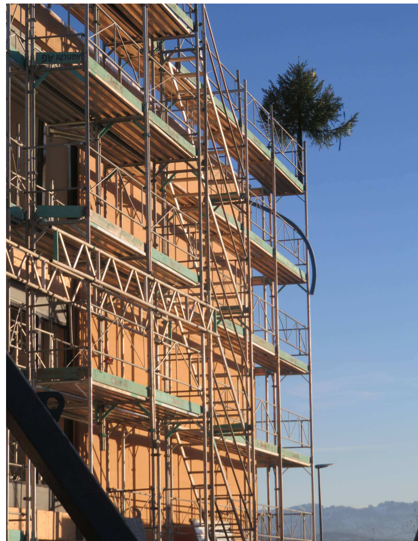
November 2017: Bei sonnigem Herbstwetter fand die offizielle Aufrichte des neuen Schulhauses im Grund statt.
